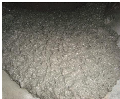
Figura 3 – Concreto no término do processo de produção
